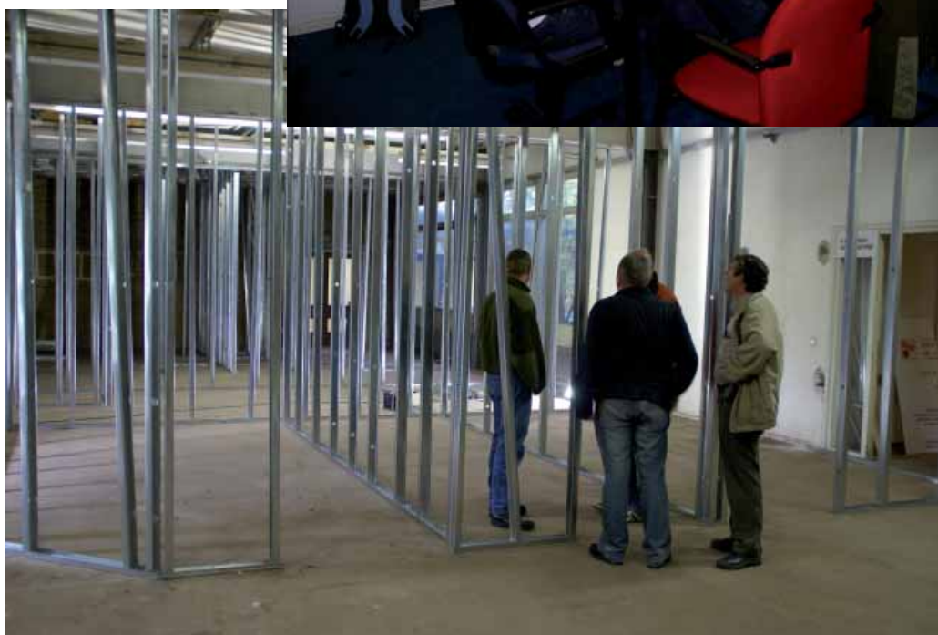
Boven: Voorbereiding bouwactiviteiten Gouda Fluwelensingel. Midden: Bouwcommissie Gouda komt bijeen Onder: Bouwcommissie Gouda volgt de bouwactiviteiten op de voet.
